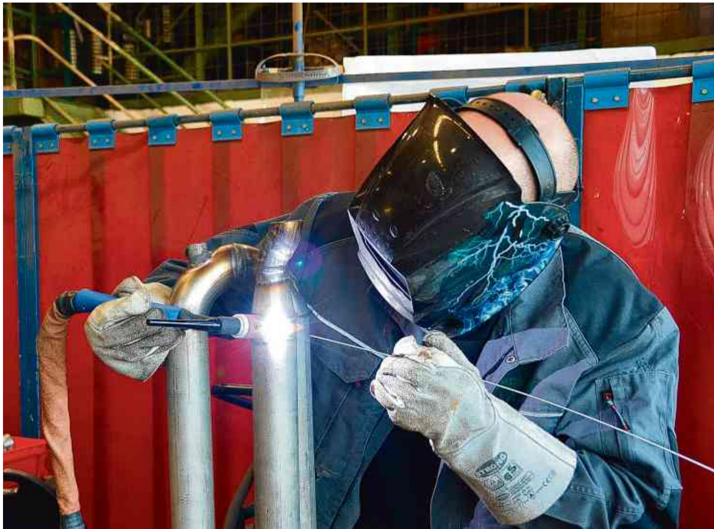
Dennis Spicher aus Loope bearbeitet alles, was ihm vors Schweißgerät kommt. Er arbeitet mit Metall-Aktivgas.
